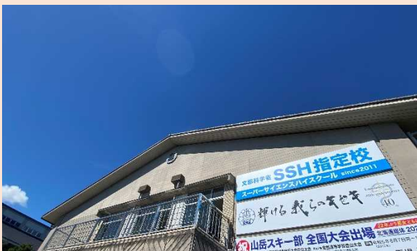
図4 管理棟正面に設置されたパネル
